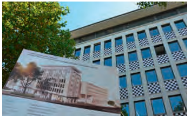
Die umgebaute Evangelische Bank in Kassel.
